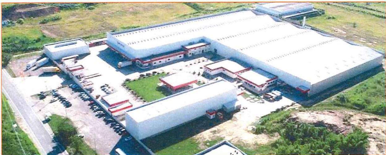
Imagem aérea da fábrica localizada no município de Paracambi/RJ
