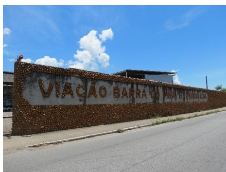
Figuras 12 Fachada do imóvel - estado de conservação
